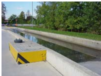
Impianto di lavaggio ruote automezzi in uscita dalla piattaforma
